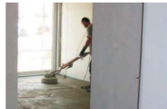
Eine qualitativ hochwertige Verlegung von Estrich muss trotz unterschiedlicher Gegebenheiten vor Ort immer gewährleistet sein, unabhängig davon, in welche Etage der Estrich gepumpt werden soll.
